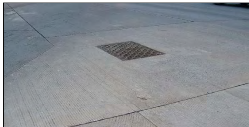
Drop Inlet CIP Closure Pour
